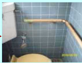
トイレにも手摺を設置
